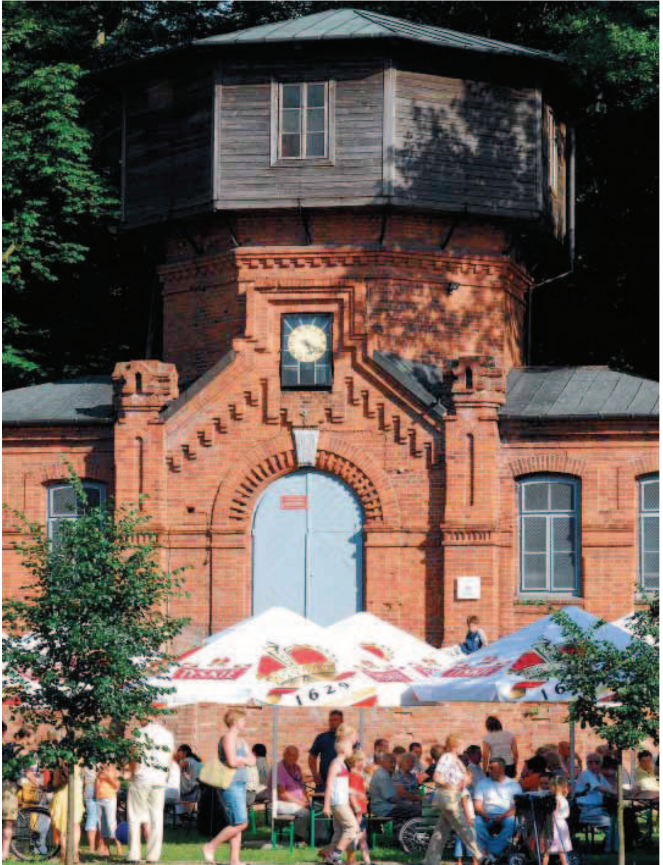
Puławy, woj. lubelskie. Wieża ciśnieniowa na terenie zespołu pałacowego Czartoryskich. Zbudowana w 1897 r. w czasie modernizacji wodociągów pochodzących z XVIII w. (foto Wodociągi Puławskie)
