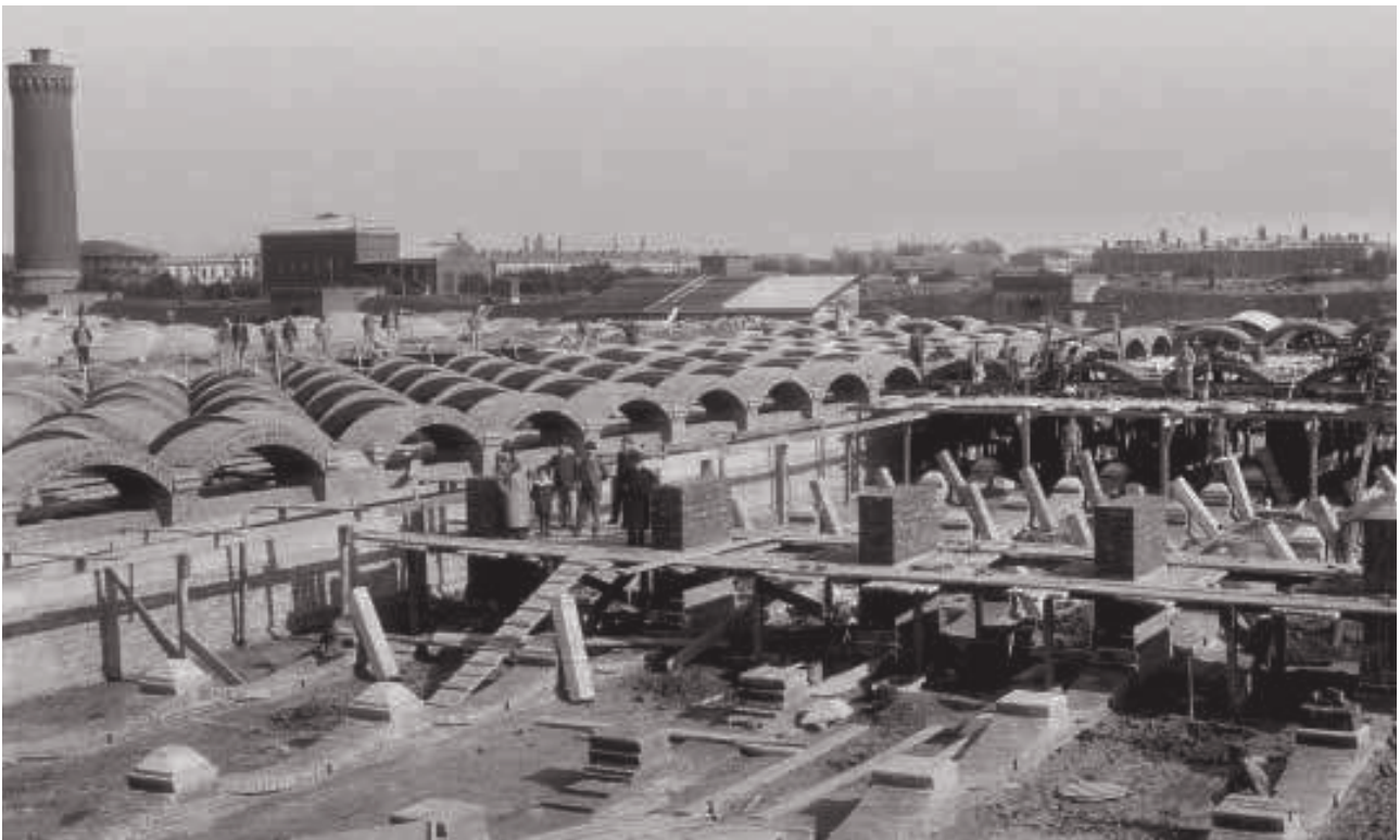
Warszawa. Budowa filtrów powolnych (arch. MPWiK Warszawa)
