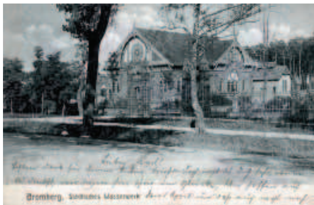
[58] Bydgoszcz. Stacja wodociągowa Las Gdański 1900 r. (arch. W. Banach)
