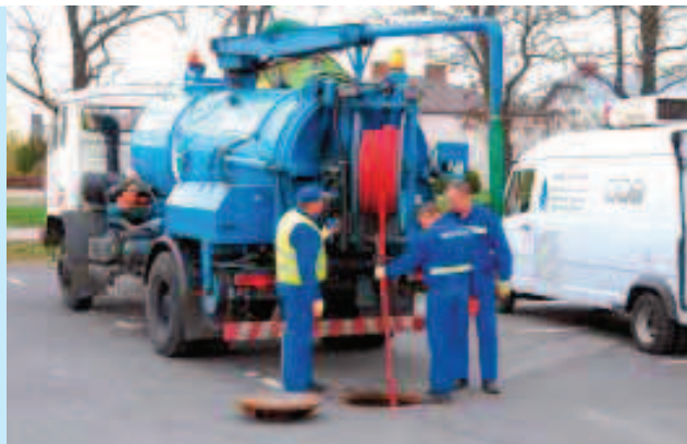
Czyszczenie kolektorów ściekowych zapewnia utrzymanie drożności systemu (fot. M. Kucharczyk)
