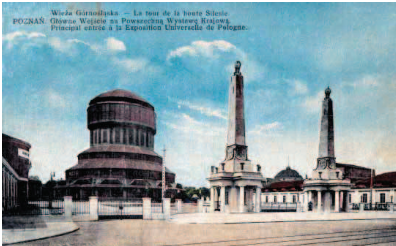
Poznań. Wieża Górnoszląska – zbudowana jako wieża ciśnieniowa, pozostała po niemieckiej wystawie przemysłowo-rolniczej z 1911 r. Zaprojektowana przez architekta Hansa Poelziga, czołowego przedstawiciela niemieckiego ekspresjonizmu. W 1945 roku, w czasie wyzwolenia Poznania, gmach ten został poważnie uszkodzony. Zamiast go naprawić rozebrano górną część, zastępując ją ażurową, strzelistą konstrukcją istniejącą do dzisiaj (arch. M. Łoś)
