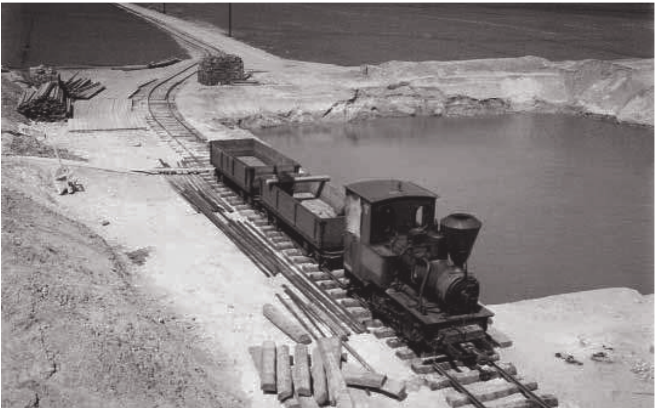
Ciuchcia jak z dziecięcego obrazka dowoziła materiały potrzebne do budowy łódzkiej kanalizacji. Na zdjęciu: żwirownia na Polesiu Konstantynowskim w Łodzi, uruchomiona przez budowniczego miejskiej kanalizacji inżyniera Stefana Skrzywaną. 1928 rok (arch. ZWiK Łódź)
