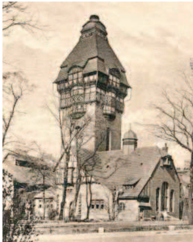
Zabrze, woj. śląskie – wieża kominowo-ciśnieniowa na terenie Szpitala Klinicznego o wys. 39 m, wzniesiona na terenie szpitala wybudowanego w 1858 r. przez górniczą Spółkę Bracką. W ramach rozbudowy szpitala realizowanej w latach 1904-1905 wg projektu berlińskiego architekta Arnolda Hartmanna, wybudowano kotłownię, maszynownię z charakterystyczną wieżą ciśnień, pralnię i kuchnię. (arch. Muzeum Miejskie w Zabrzu)
