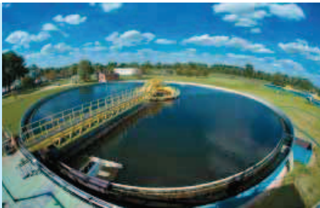
Oczyszczalnia ścieków MPWiK Warszawa (fot. K. Kobus TravelPhoto)
