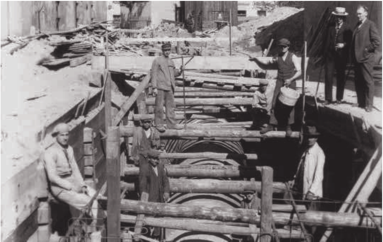
Zielona Góra. Budowa kanalizacji przy ul. Młyńskiej – 1928 r. (arch. Zielonogórskie Wodociągi i Kanalizacja)
