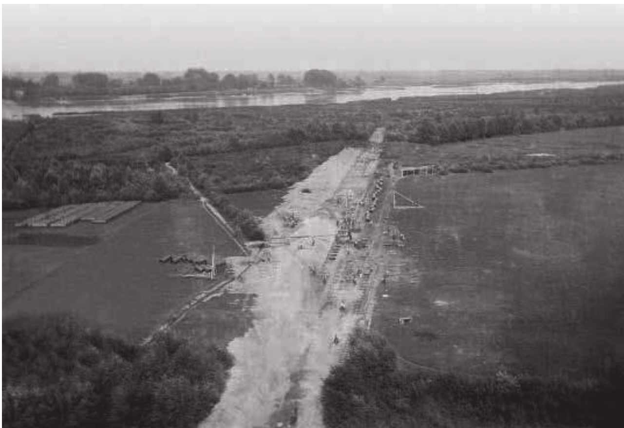
Warszawa. Układanie przewodu ssawnego na stacji pomp rzecznych (arch. MPWiK Warszawa)
