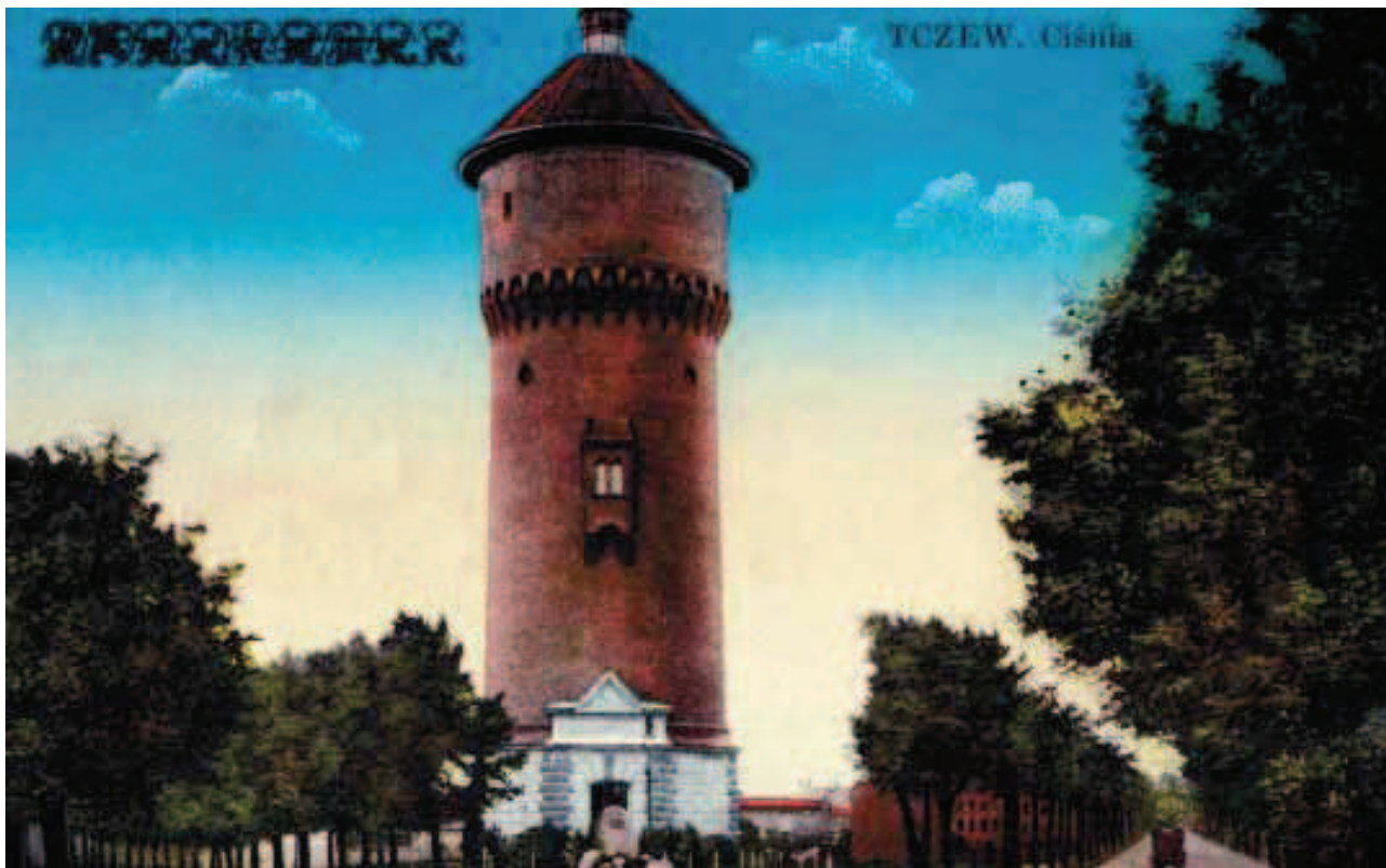
Tczew, ul. Bałdowska 1, woj. pomorskie. Wieża ciśnienia z 1905 roku (arch. M. Łoś)
