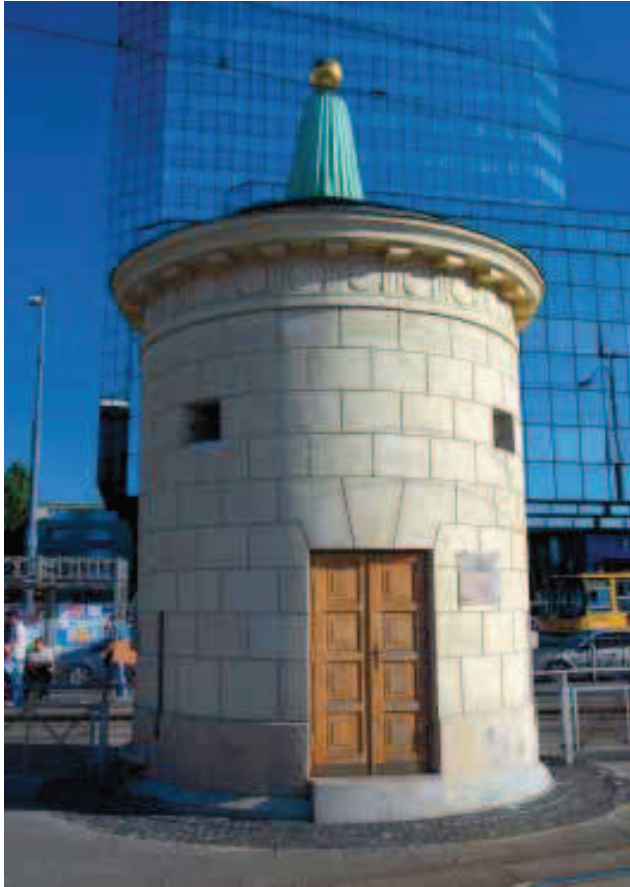
[43] Warszawa, al. Solidarności – zabytkowy wodozbiór na nieistniejącym już placu Tłomackim zbudowany (1783-87) wg projektu wybitnego architekta Szymona Zuga. Rotunda z powodu formy nazwana przez mieszkańców „Grubą Kaśką”. (foto M. Kucharczyk)
