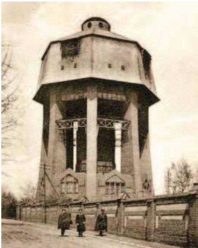
Zabrze, woj. śląskie – wieża ciśnień przy ul. Zamoyskiego (wys. 46 m, pojemność rezerwuaru 2 tys. m 3 ) wybudowana w latach 1907-1909 dostarczała wodę dla znacznej części Zabrza, Maciejowa, Sońnicy i warsztatów naprawy lokomotyw w Gliwicach. Jej projekt wykonali architekt August Kind i królewski radca budowlany Friedrich Loose. Na dole mieściły się kiedyś mieszkania i biura. (arch. Muzeum Miejskie w Zabrzu)
