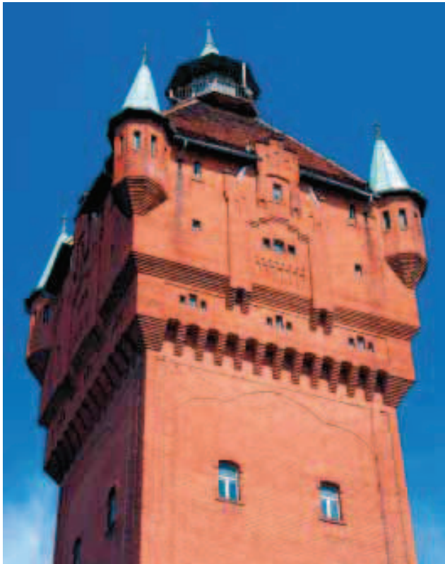
Śrem, woj. wielkopolskie – wieża wodociągowa (wys. 44 m), zbudowana w 1908-1909 r. wg projektu K. Geislera (foto M. Kucharczyk)
