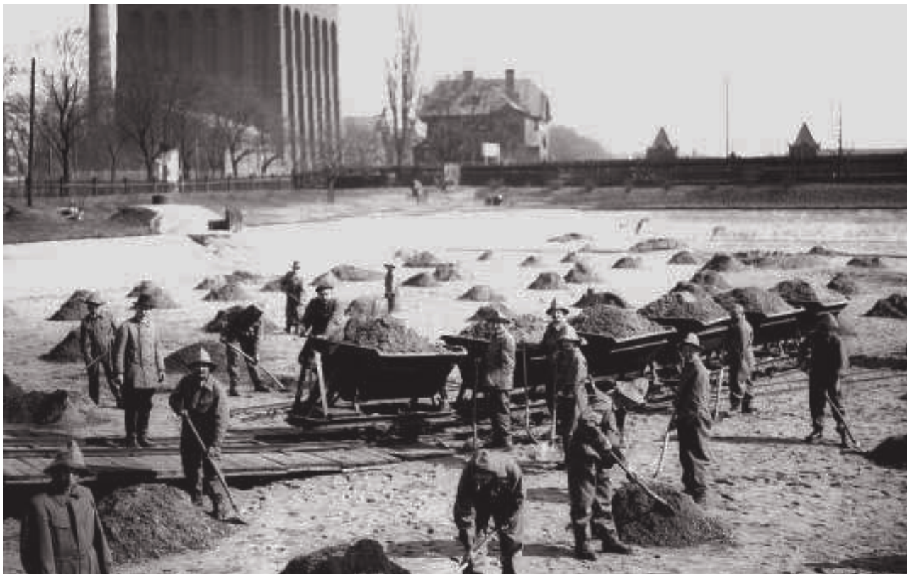
Wrocław. Oczyszczanie złoża filtra powolnego, lata międzywojenne (arch. MPWiK Wrocław)
