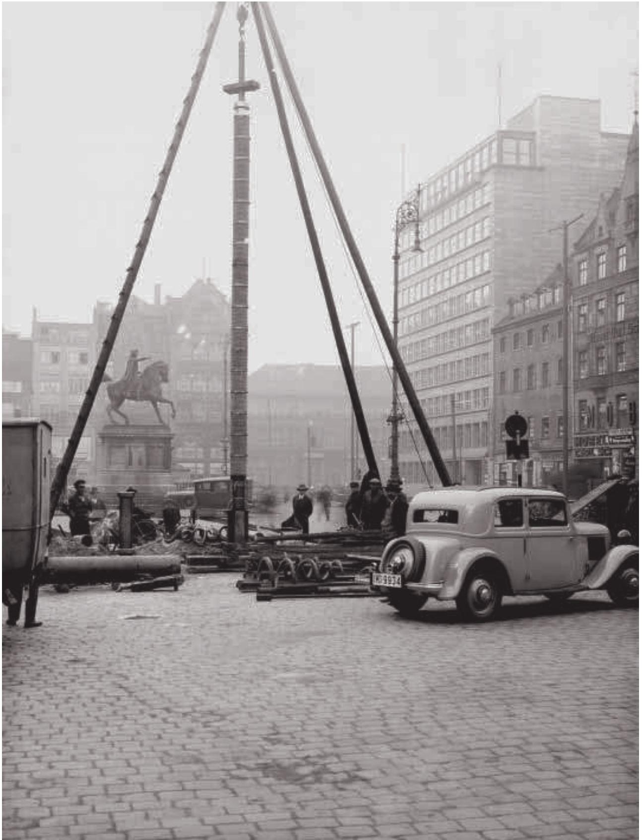
Prace wiertnicze przy studni publicznej na wrocławskim Rynku, lata 30. XX w. (arch. MPWiK Wrocław)
