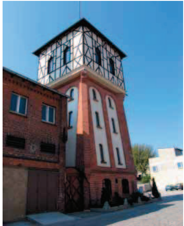
Grudziądz, woj. kujawsko-pomorskie. Wieża wodna dawniej fabryki Ventzki – obecnie wyremontowana i wykorzystywana na cele mieszkalne (foto M. Łoś)
