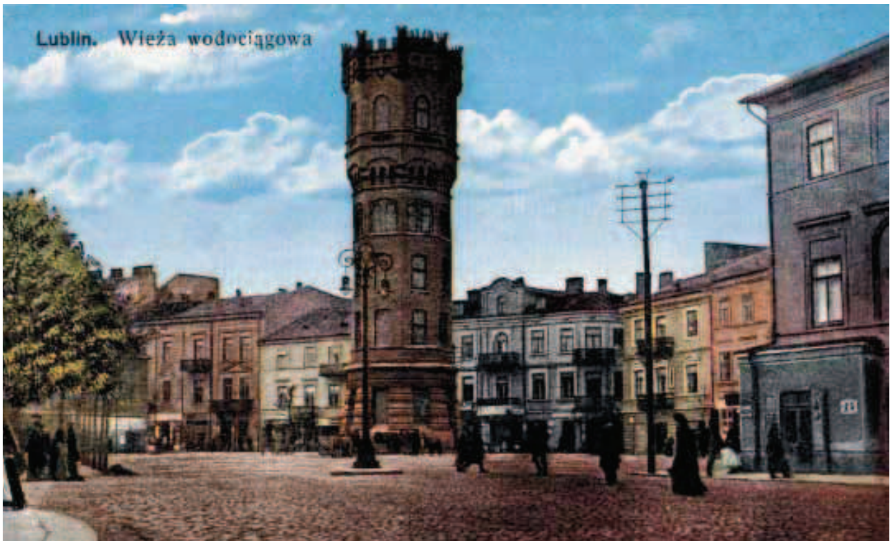
Lublin – rozebrana w 1945 r. wieża ciśniń z 1899 r. (arch. M. Łoś) przypominająca średniowieczną basztę, doczekała się w 2004 r. repliki w postaci fontanny z brązu. W uroczystości uruchomienia fontanny uczestniczyła Maria Mazurkiewicz, która urodziła się w wieży, spędziła w niej wczesne lata swojego dzieciństwa i doskonale pamiętała swój pierwszy „dom”.
