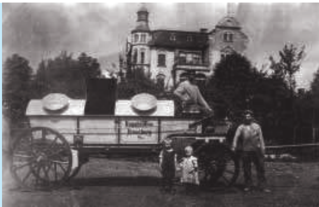
[80] Kluczbork. Ekipa do konserwacji kanalizacji (arch. Hydrokom Kluczbork)
