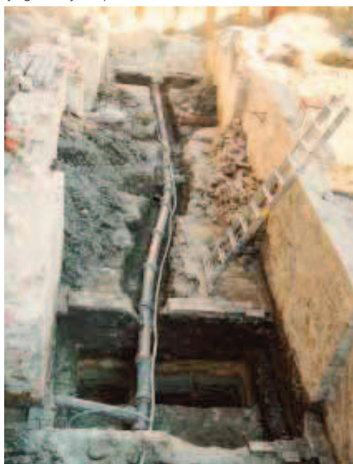
[73] Bydgoszcz, ul. Mostowa 4. Kamionkowa kanalizacja i ołowiany wodociąg z pocz. XX w. (foto W. Siwiak)
