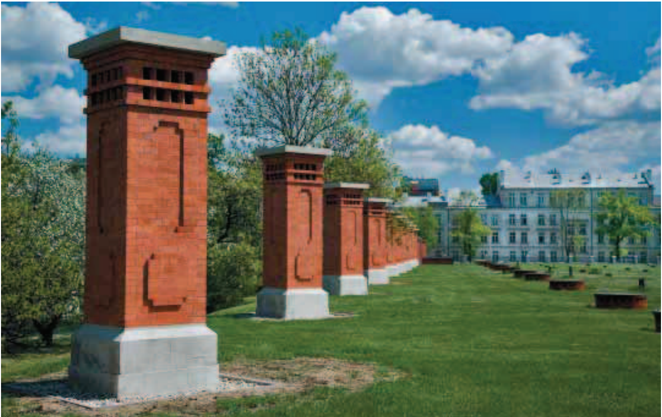
Warszawa. Kominki wentylacyjne na podziemnych zbiornikach wody czystej (foto K. Kobus / TravelPhoto)
