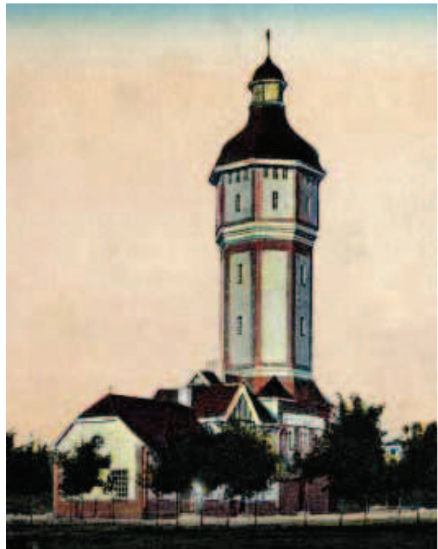
Śmigiel, woj. wielkopolskie. Wieża ciśnieniowa (arch. M. Łoś)
