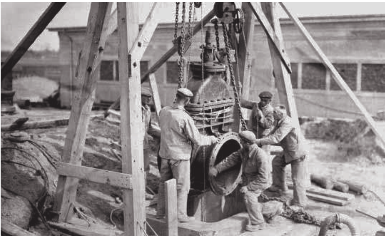
Montaż ogromnych zasuw na magistrali wodociągowej o średnicy 750 mm podczas budowy Stacji Uzdatniania Wody na Dąbrowie w Łodzi. 1937 r. – (arch. ZWiK Łódź)
