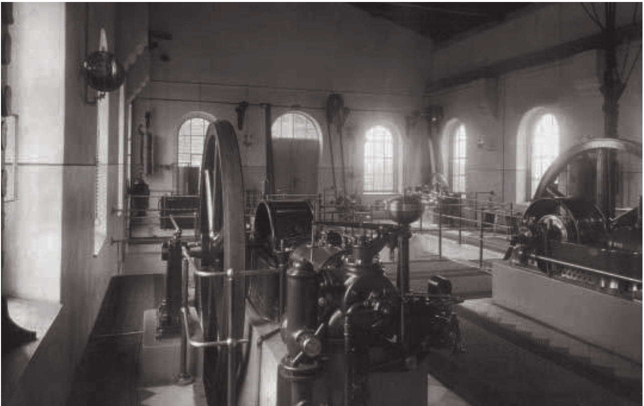
Kluczbork. Hala maszyn przepompowni ścieków 1938 rok (arch. Hydrokom Kluczbork)
