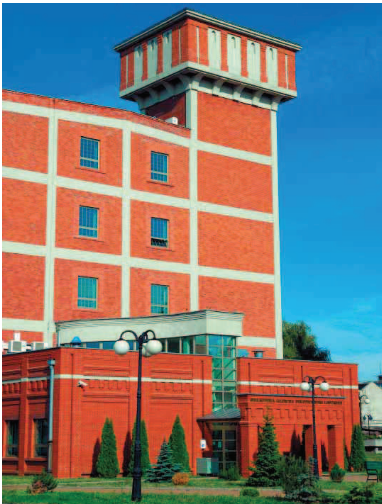
[63] Łódź – narożna wieża wodna z 1913 r stanowiąca część budynku składu w fabryce Schweikerta. Obecnie – Biblioteka Główna Politechniki Łódzkiej (foto M. Kucharzyk)
