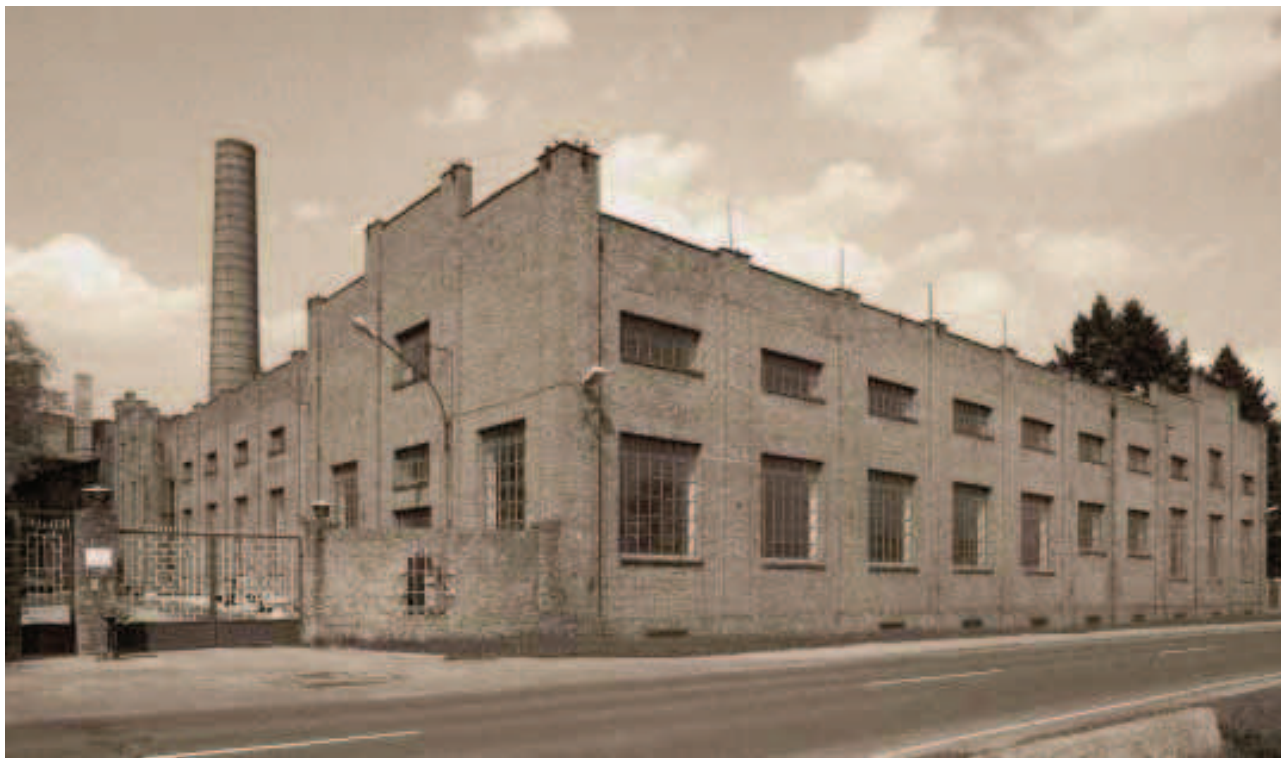
Karchowice, woj. śląskie – zabytkowy Zakład Produkcji Wody „Zawada” – 1894-1895 r. (foto Urząd Marszałkowski Województwo Śląskiego w Katowicach)
