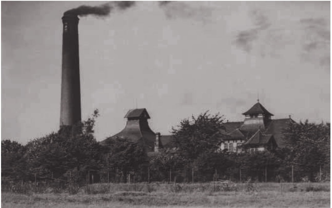
Pompownia „Świątyniki” we Wrocławiu, wybudowana w latach 1902-1904 (arch. MPWiK Wrocław)
