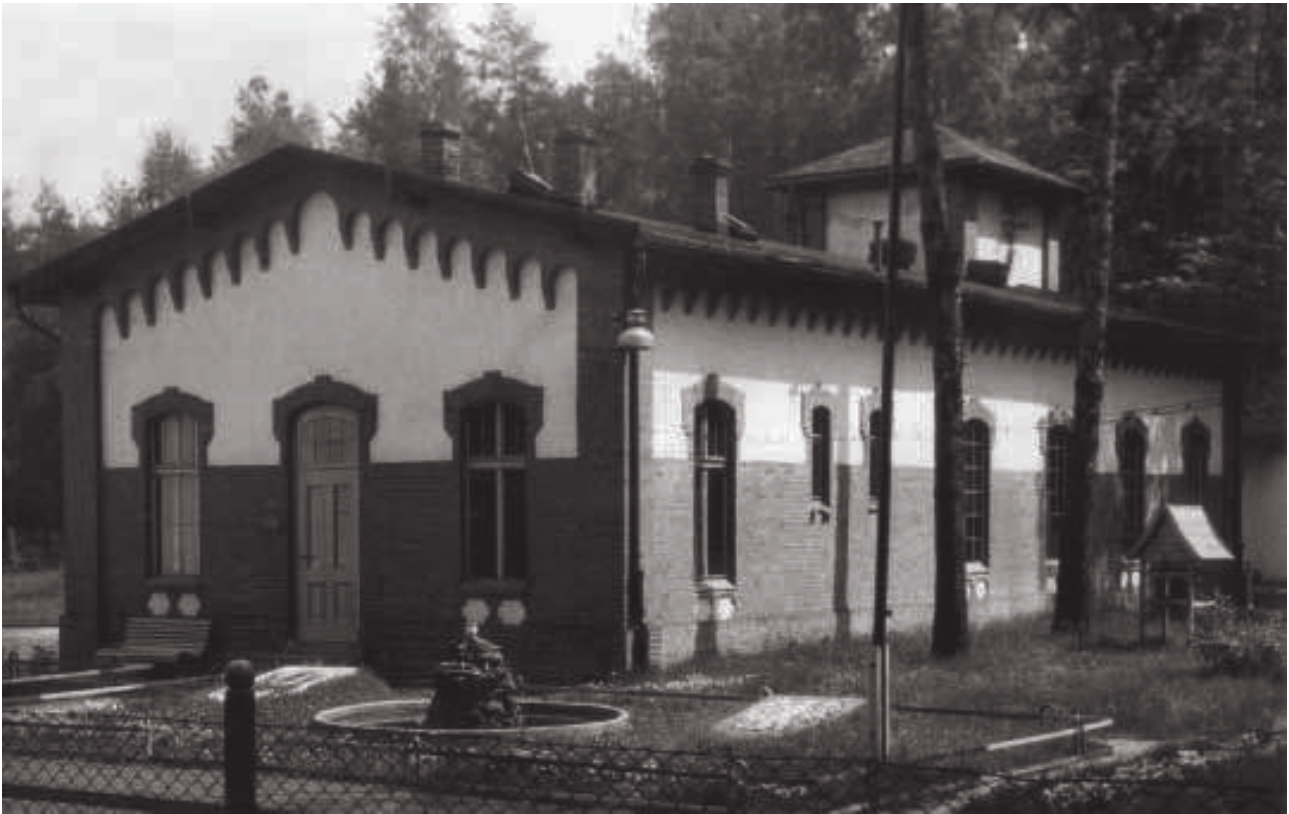
Kluczbork. Stacja uzdatniania wody ok. 1950 rok (arch. Hydrokom Kluczbork)
