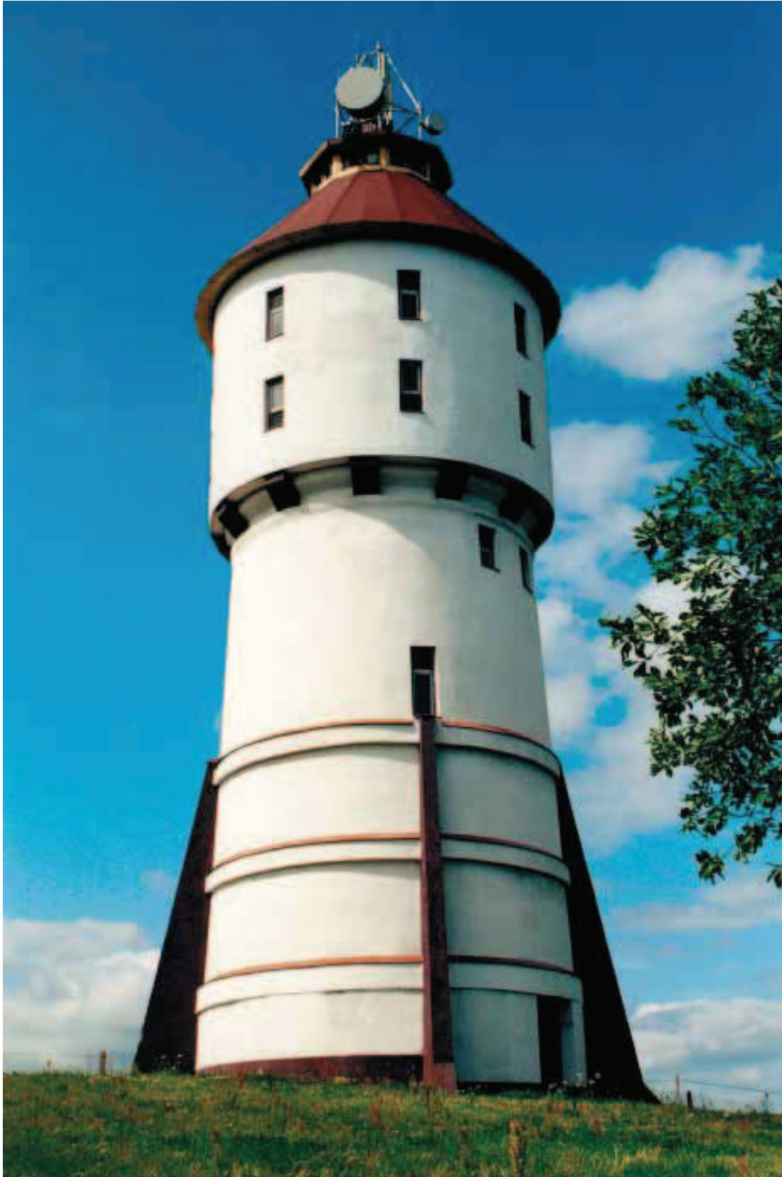
Węgorzewo, woj. warmińsko-mazurskie. Wciąż funkcjonująca 20 metrowa wieża ciśnień wybudowana w latach 1904-1905 posadowiona na wzgórzu nad jeziorem Święcajty (foto M. Łoś)
