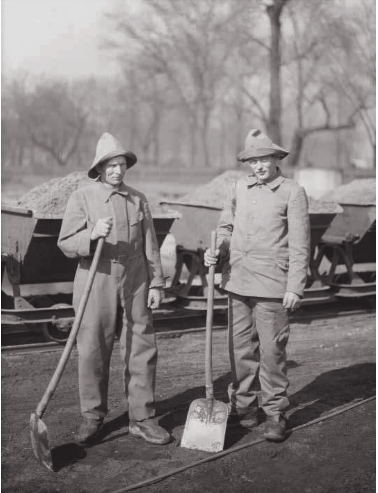
Wrocław. Pracownicy czyszczący filtry, lata międzywojenne (arch. MPWiK Wrocław)
