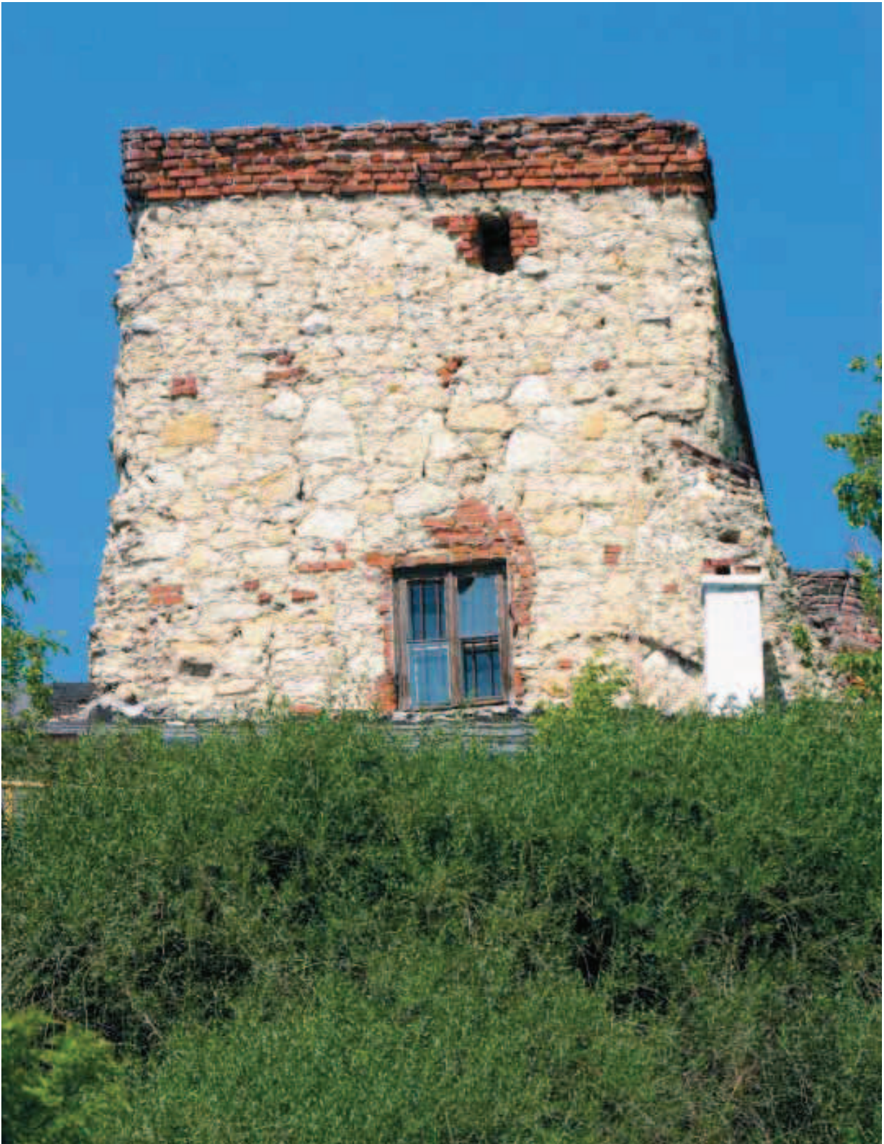
[33] Lublin. Wieża wodna z 1564 r. zbudowana z łupanego kamienia wapiennego oraz z cegły z czterospadowym dachem. Ze zbiornika z wieży woda sphywała grawitacyjnie drewnianymi rurami do browarów, kamienic bogatych mieszczan, klasztorów, szpitala przy kościele św. Ducha, łaźni i publicznych studzienek miejskich (foto MPWiK w Lublinie / arch. MPWiK Lublin)
