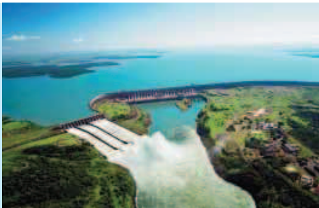
Itaipu – zaporą na rzece Parana w Ameryce Południowej będącą wspólnym przedsięwzięciem Brazylii i Paragwaju. (©Photofactory®)
