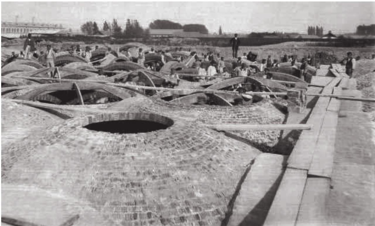
Warszawa. Budowa filtrów powolnych (arch. MPWiK Warszawa)
