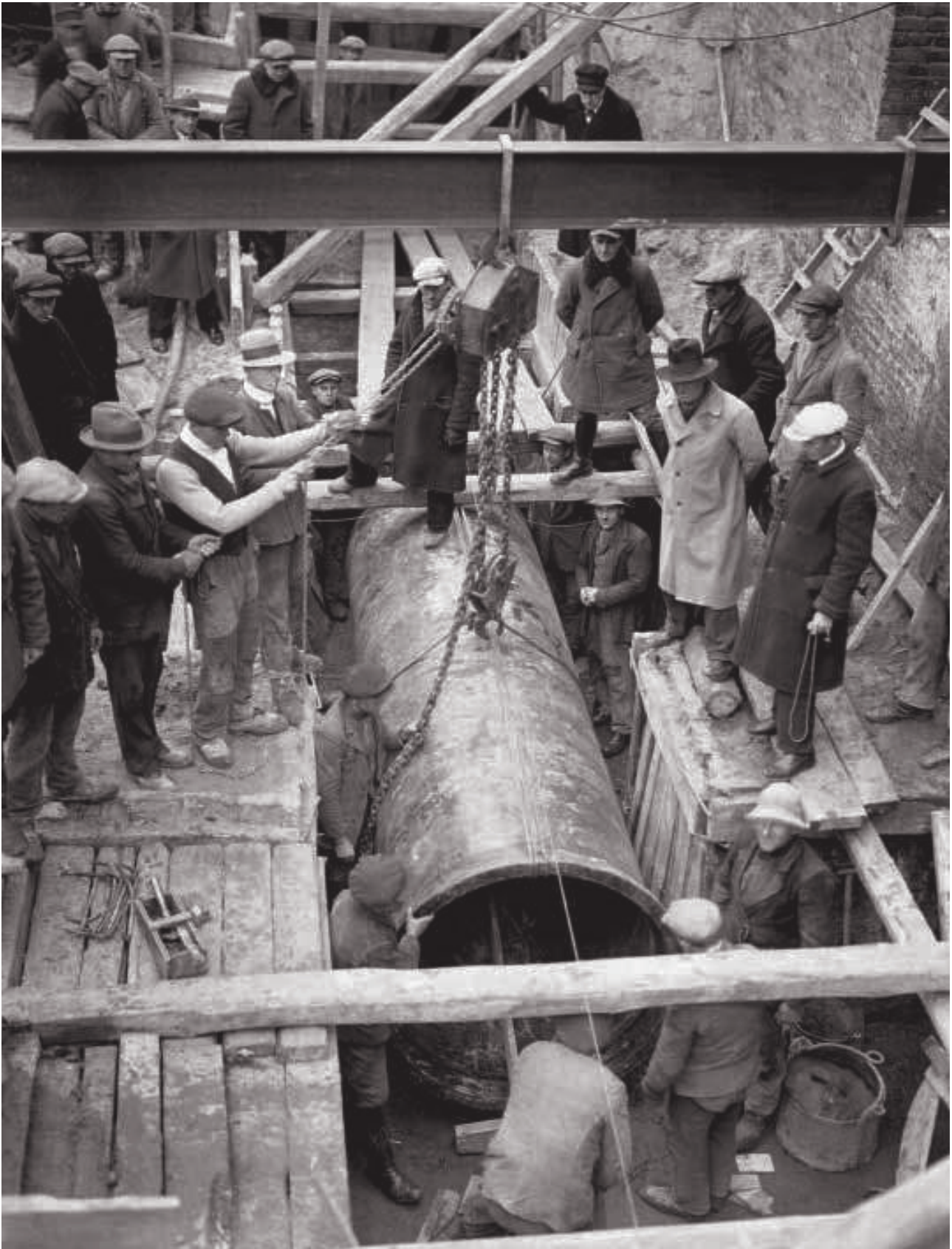
[66] Łódź. Budowa wodociągu – lata 30 XX w. – 1930s (arch. ZWIK Łódź)
