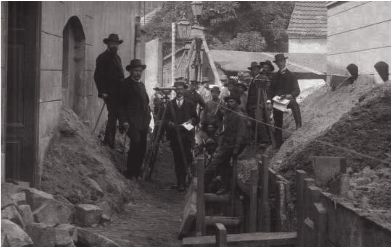
Kluczbork. Budowa kolektora sieci kanalizacyjnej 1909 rok (arch. Hydrokom Kluczbork)
