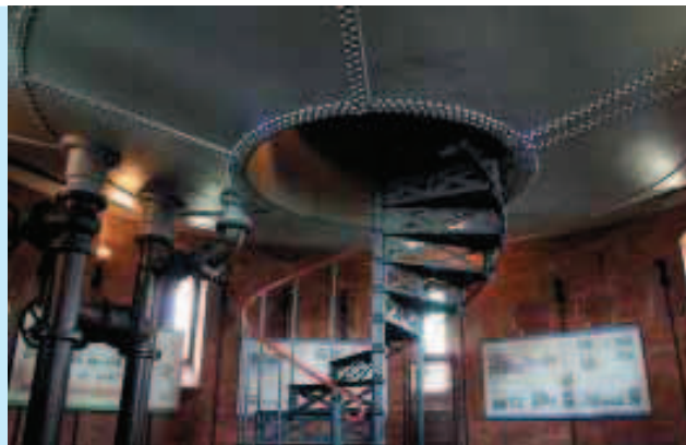
[52] Toruń. Wnętrze wieży ciśnieniowej. (foto M. Łoś)
