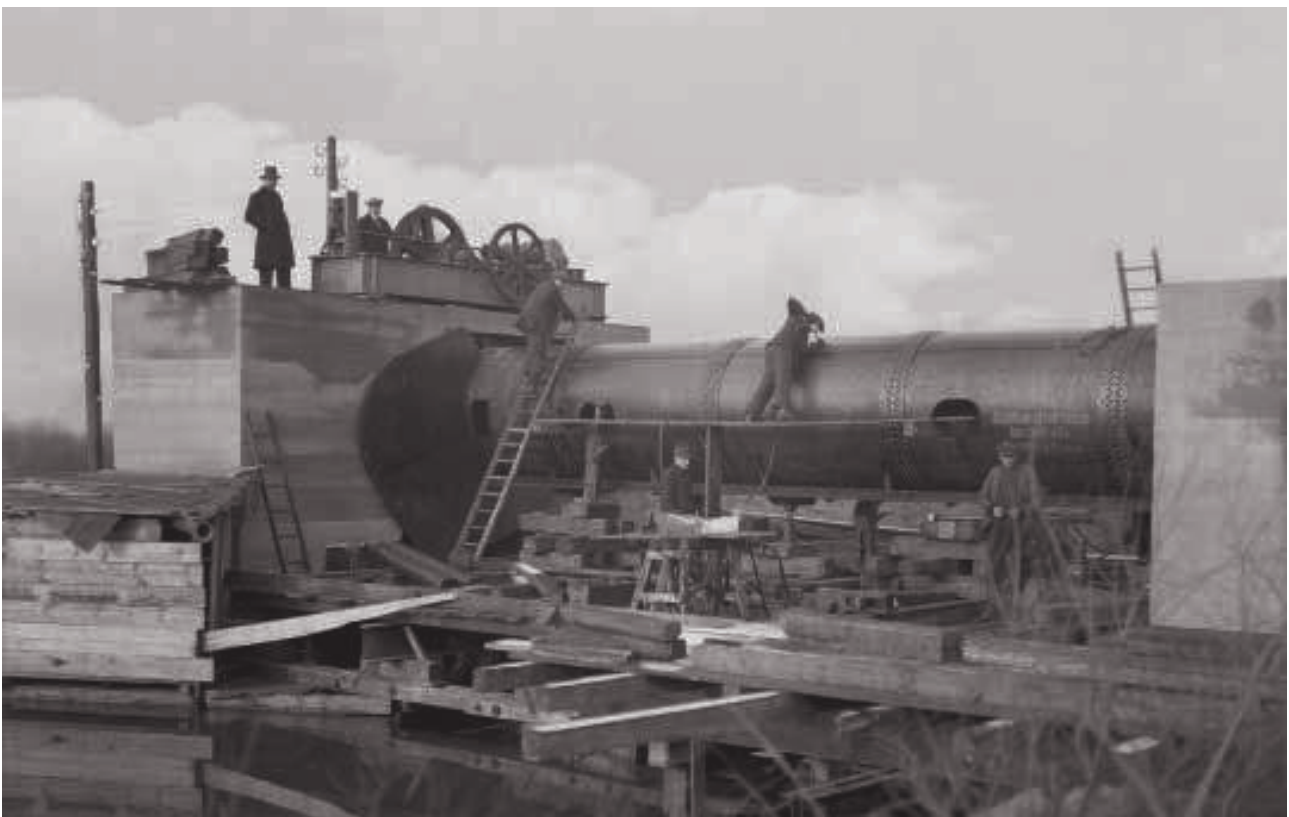
Budowa jazu walcowego na wrocławskich terenach wodonośnych (arch. MPWiK Wrocław)
