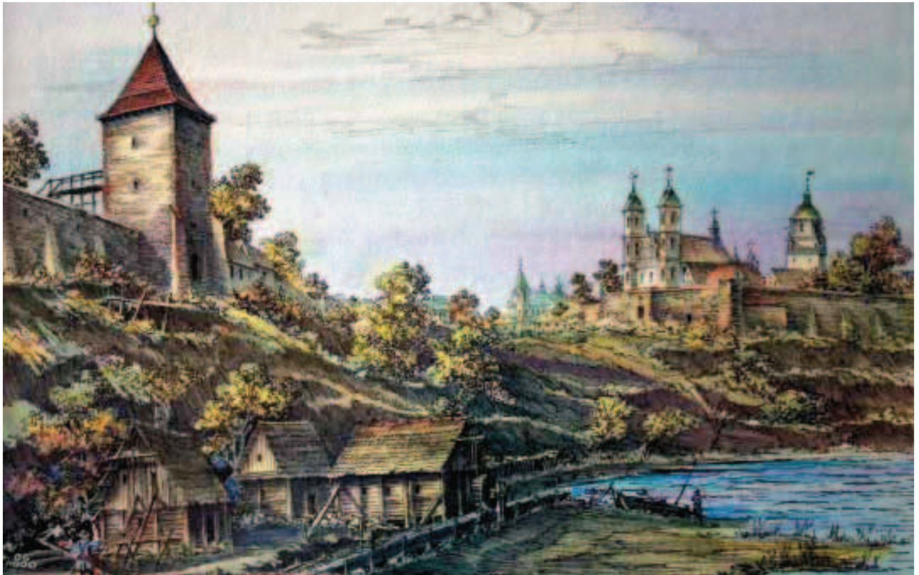
[34] Lublin. Wodociąg zbudowany przez mistrza Jana funkcjonował półtora wieku dostarczając 95.000 litrów wody na dobę. (arch. MPWiK Lublin)
