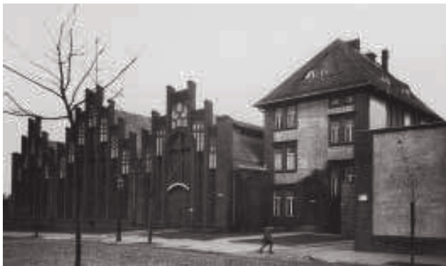
[69] Poznań. Przepompownia ścieków (foto Aquanet SA)
