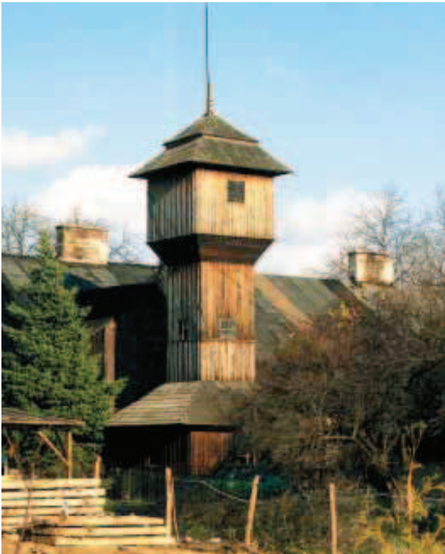
Zamość, woj. lubelskie – drewniana wieża ciśniń (wys. 12,9 m, ok. 600 litrów) wzniesiona w 1895 r. przez H. Modzelewskiego, oprócz mieszkańców zaopatrywała w wodę pobliskie ogrody i szklarnie (foto H. Szkutnik)
