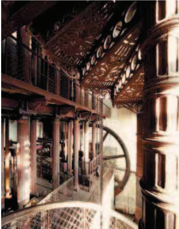
We wnętrzu wrocławskiej wieży ciśnień przy ul. Na Grobli mieści się przechodząca przez cztery kondygnacje maszyna parowa z kołami zamachowymi o średnicy 7,5 metra (foto M. Bury)
