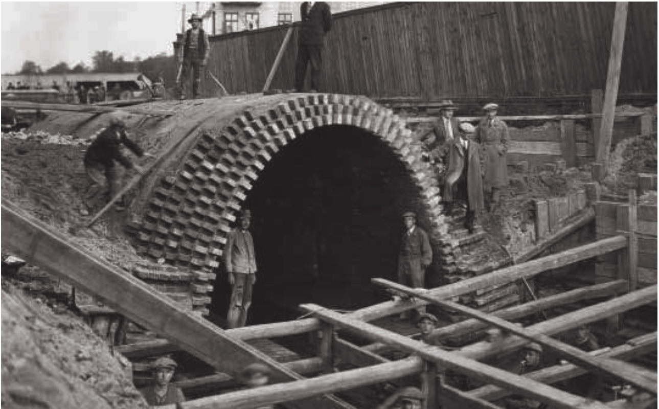
Prace przy budowie kanału (przelewu) burzowego w Łodzi, 1931 r. To jeden z kilkunastu przelewów burzowych – zaprojektowano go do odprowadzania bezpośrednio do rzek nadmiaru wód deszczowych, których podczas gwałtownych ulew nie jest w stanie pomieścić miejska kanalizacja (arch. ZWiK Łódź)
