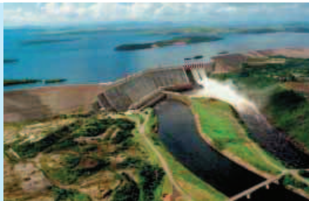
Guri – hydroelektrownia we wschodniej Wenezueli na rzece Caroni: zapora wys. 162 m, zbiornik retencyjny 4,2 tys. km 2 . (©Photofactory®)
