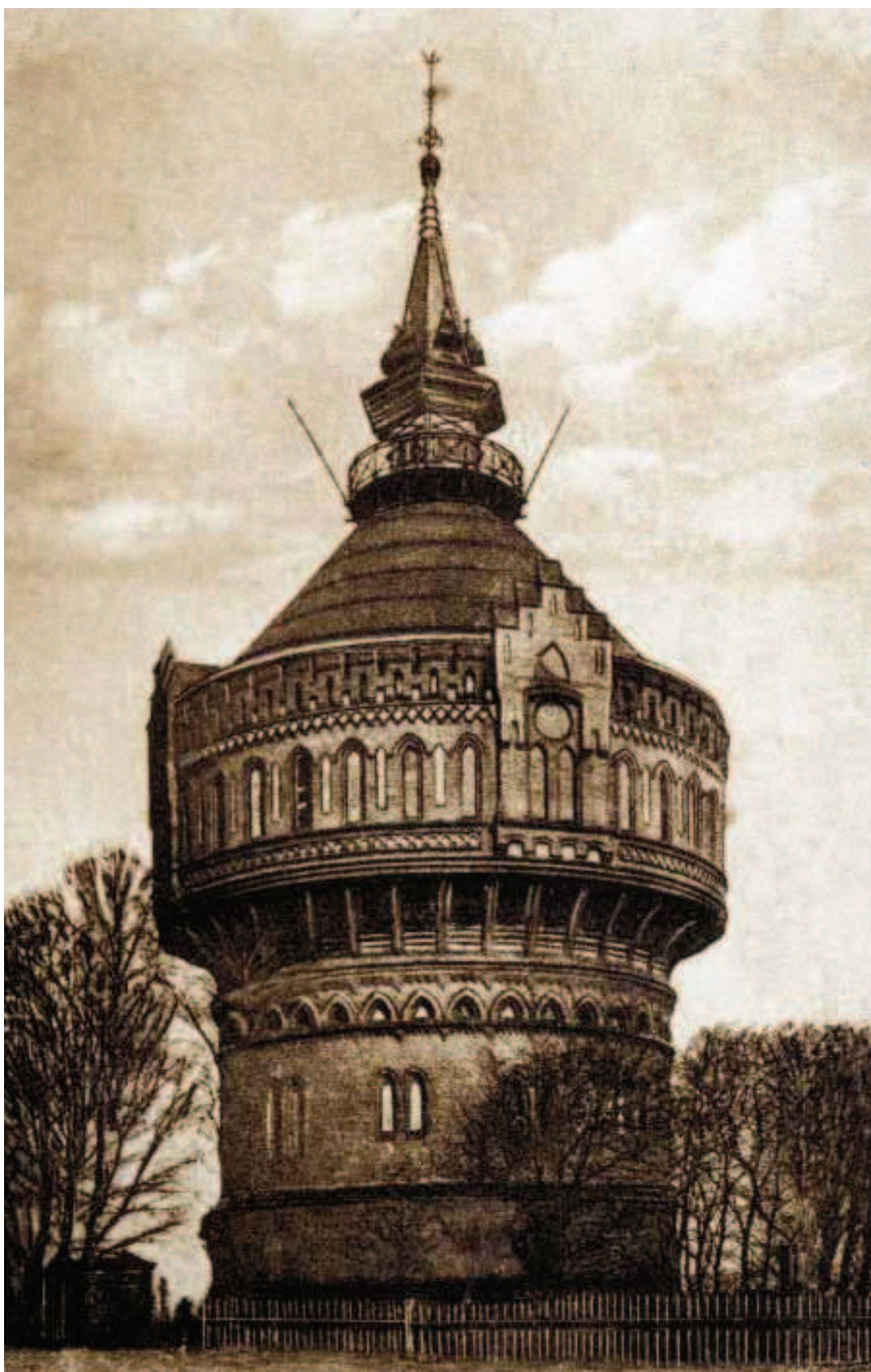
Bydgoszcz. Wieża ciśnień z 1900 r. jest przysadzistą mурowaną bryłą cylindryczną. Zbiornik umieszczono w wykuszu. Bogato zdobione są zarówno gzymsy pod wykuszem, jak i sam wykusz. Część zbiornikowa z wąskimi, strzelistymi oknami, dekoracyjną attyką, zdobnymi blankami i szczytami nawiązuje do stylu neogotyckiego, a jej ornamentacja wykonana z cegły profilowanej, do wczesnego baroku. Nad częścią zbiornikową znajduje się stożkowy dach z latarnią i pomostem obserwacyjnym, a powyżej stroma wieżyczka z 6 oknami facjatownymi i iglicą (arch. W. Banach)
