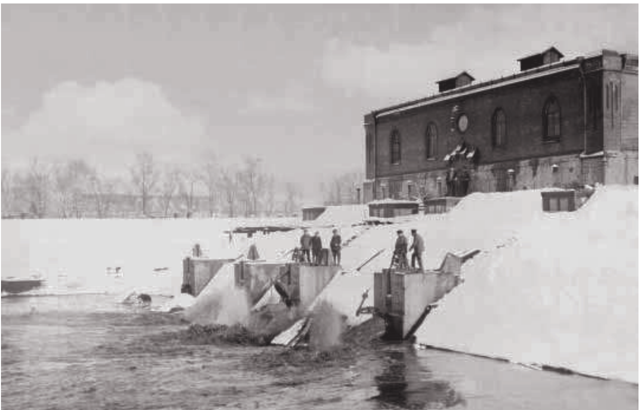
Spust osadów z odżelaziacza przy zakładzie „Na Grobli” we Wrocławiu (arch. MPWiK Wrocław)
