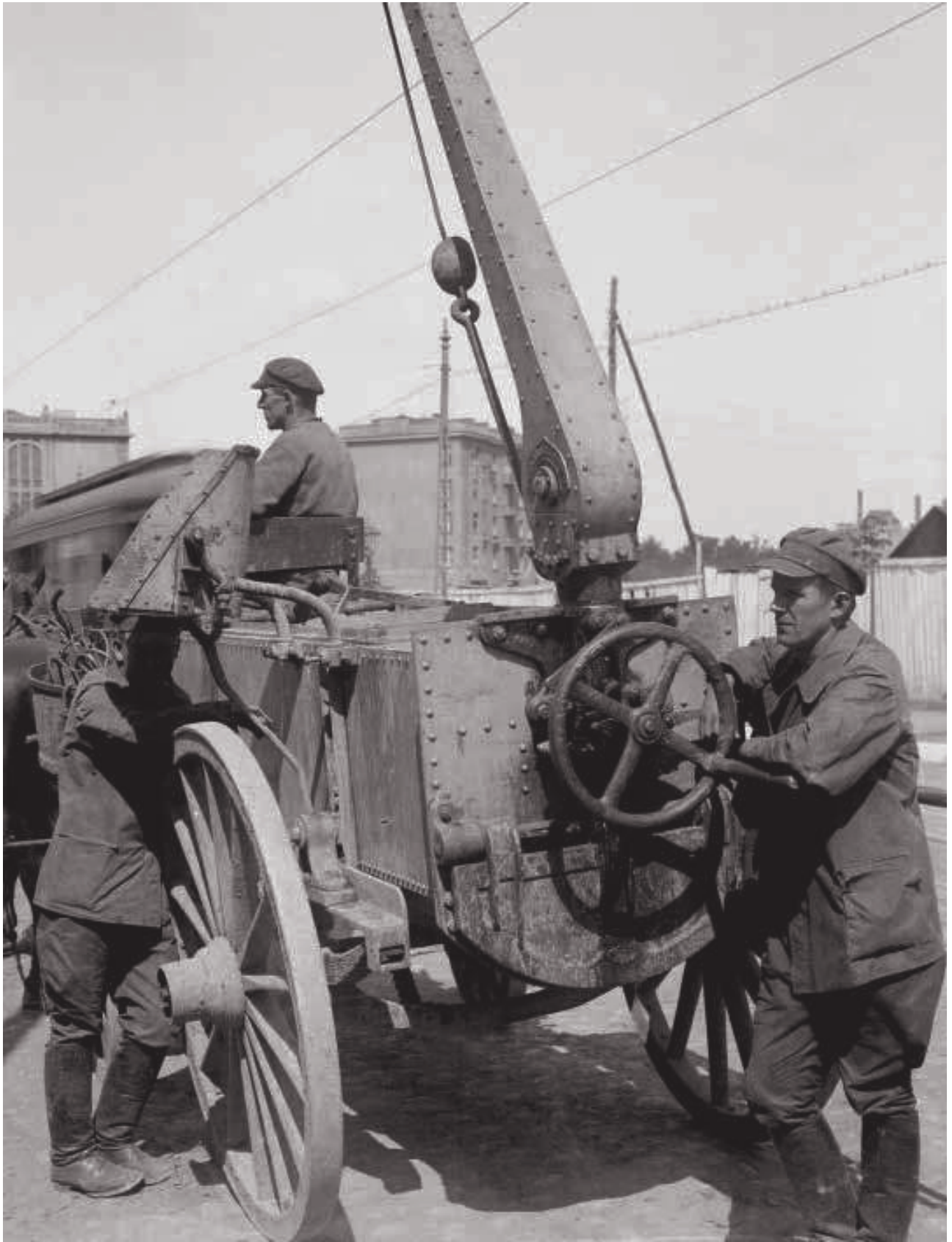
Łódź. Dźwig o napędzie ręcznym. Między innymi takich maszyn używano w latach 20. i 30. ubiegłego wieku przy budowie miejskiej kanalizacji i wodociągów w Łodzi (arch. ZWiK Łódź)
