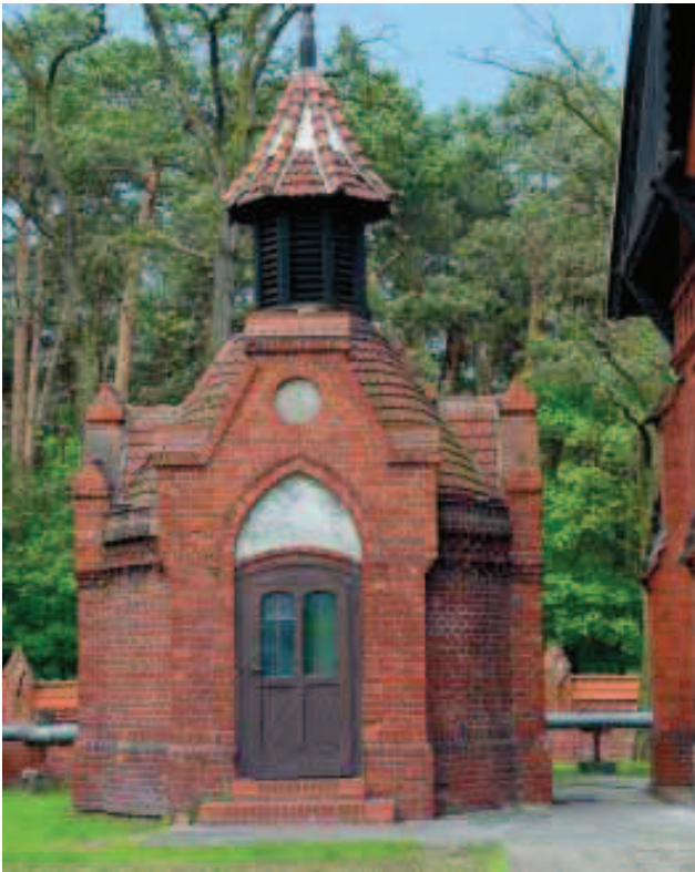
Bydgoszcz. Uruchomienie w 1900 r. stacji wodociągowej Las Gdański (@Photofactory®)
