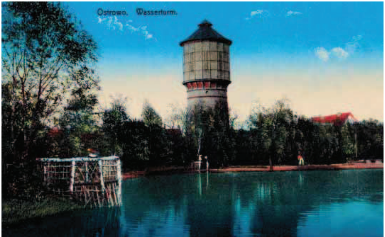
Wodociąg Ostrowa Wlkp. od początku bazuje na wodach podziemnych z pokładów czwartorzędowych. Ujęcie wody zostało zlokalizowane w dolinie rzeki Ołobok w 1903 r. (arch. M. Łoś)
