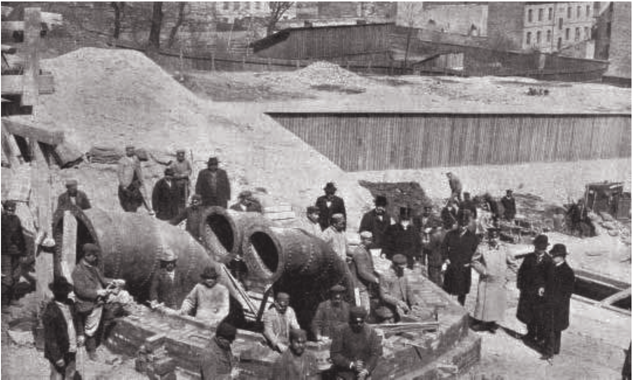
Warszawa. Budowa kanału burzowego (arch. MPWiK Warszawa)
