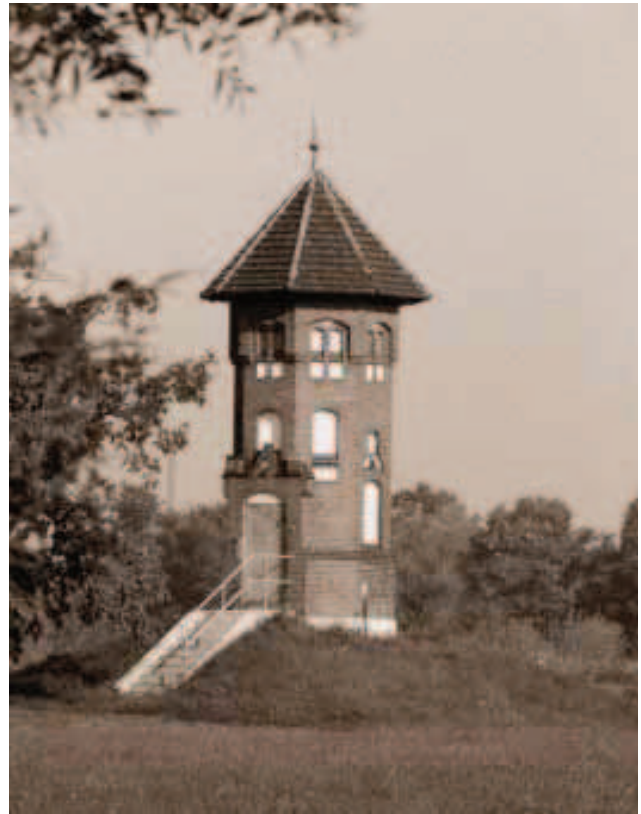
Jedna z ośmiu wież odpowietrzających, które zdobią wrocławskie tereny wodonośne (foto J. Pasierski)
