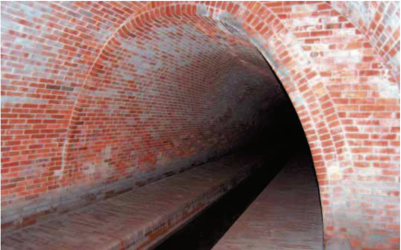
Łódź. „Gwiazda” (poniżej) – nietypowy wjazd do zejścia bocznego, prowadzącego do komory łączącej dwa najstarsze łódzkie kolektory i przelew burzowy. Budowę łódzkiej kanalizacji zaczęto właśnie od tych kanałów w 1925 roku, należą one do największych podziemnych budowli. Wrażenie robi burzowiec (powyżej) o przekroju dzwonu – bez trudu mógłby przejechać nim autobus komunikacji miejskiej (foto MPWiK Łódź)
