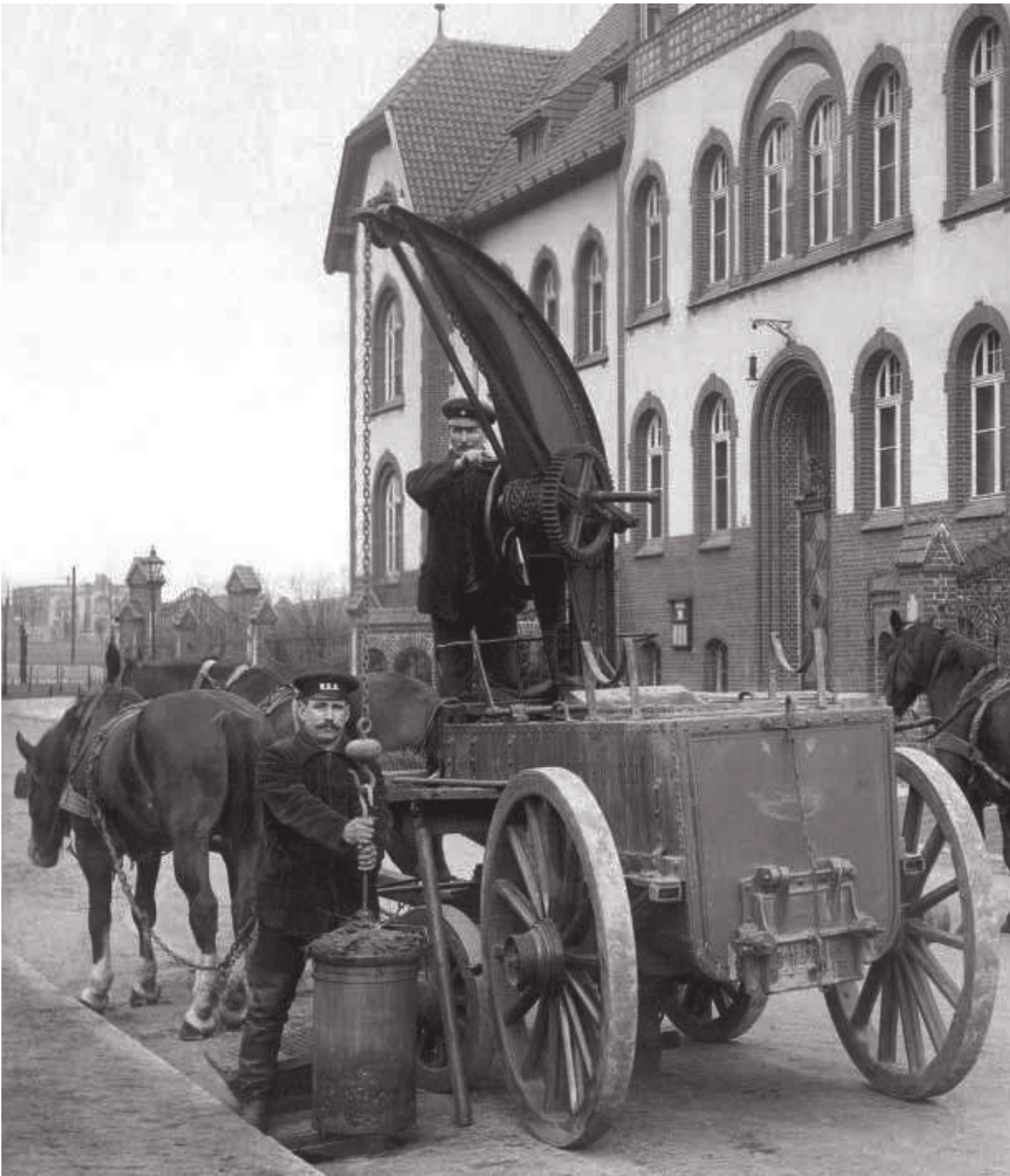
Bydgoszcz. Czyszczenie kanalizacji deszczowej na pl. J. Weysenhoffa (foto ze zbiorów Muzeum Okręgowego w Bydgoszczy)
