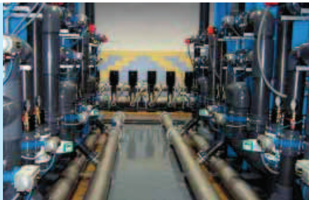
Stacja uzdatniania wody – hala pomp i filtrów – Biała Podlaska.
