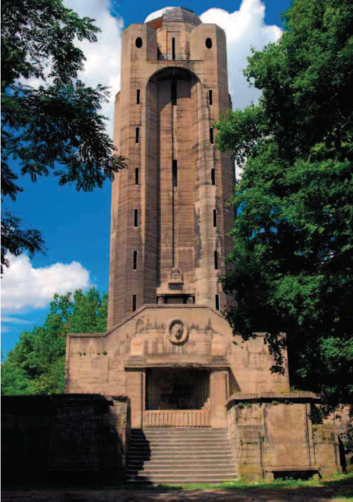
Nysa, woj. opolskie – Bismarckturm (1907 r.) – takie monumentalne wieże wznoszono jako swoiste pomniki dla uczczenia kanclerza Otto Bismarcka – wokół organizowano różne uroczystości narodowo-patriotyczne. W 1924 wieżę zaadaptowano do potrzeb wodociagowych (funkcjonowała do II wojny światowej) (foto M. Kucharczyk)
