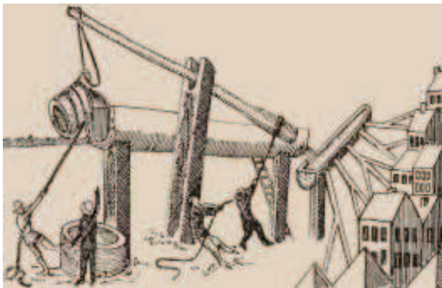
[14] Wodociąg z XV w. – drzeworyt z 1550 r.
