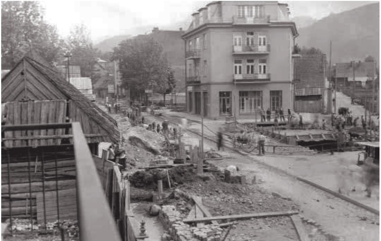
Zakopane, woj. małopolskie – budowa kanalizacji na ul. Krupówki – foto Stanisław Mirecki – 1937 r. (arch. WBZM)
