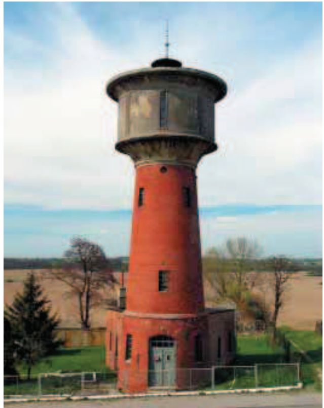
Radzyń Chełmiński, woj. kujawsko-pomorskie. Wieża wodna (foto M. Łoś)
