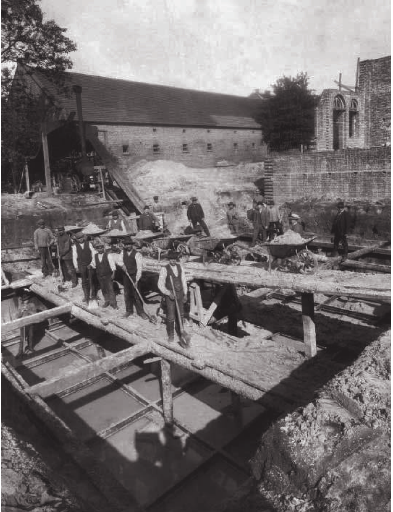
Kluczbork. Budowa przepompowni ścieków 1906 rok (arch. Hydrokom Kluczbork)
