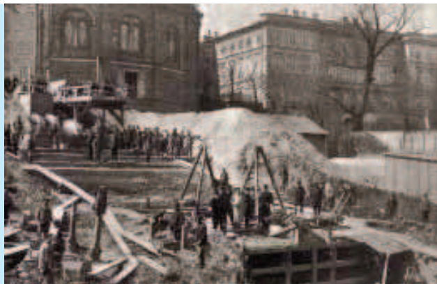
[40] Budowa kanału burzowego w Warszawie (arch. MPWiK Warszawa)
