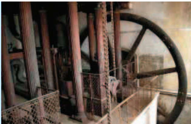
[54] Wrocław. Wnętrze wieży ciśnieniowej Na Grobli (foto W. Siwiak)
