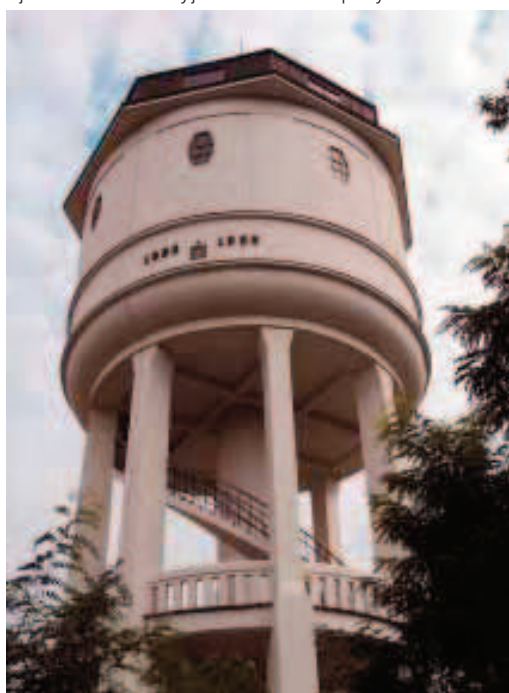
[61] Białostok. Wieża ciśnien – 1923-1925 r. (foto Wodociągi Białostockie )
