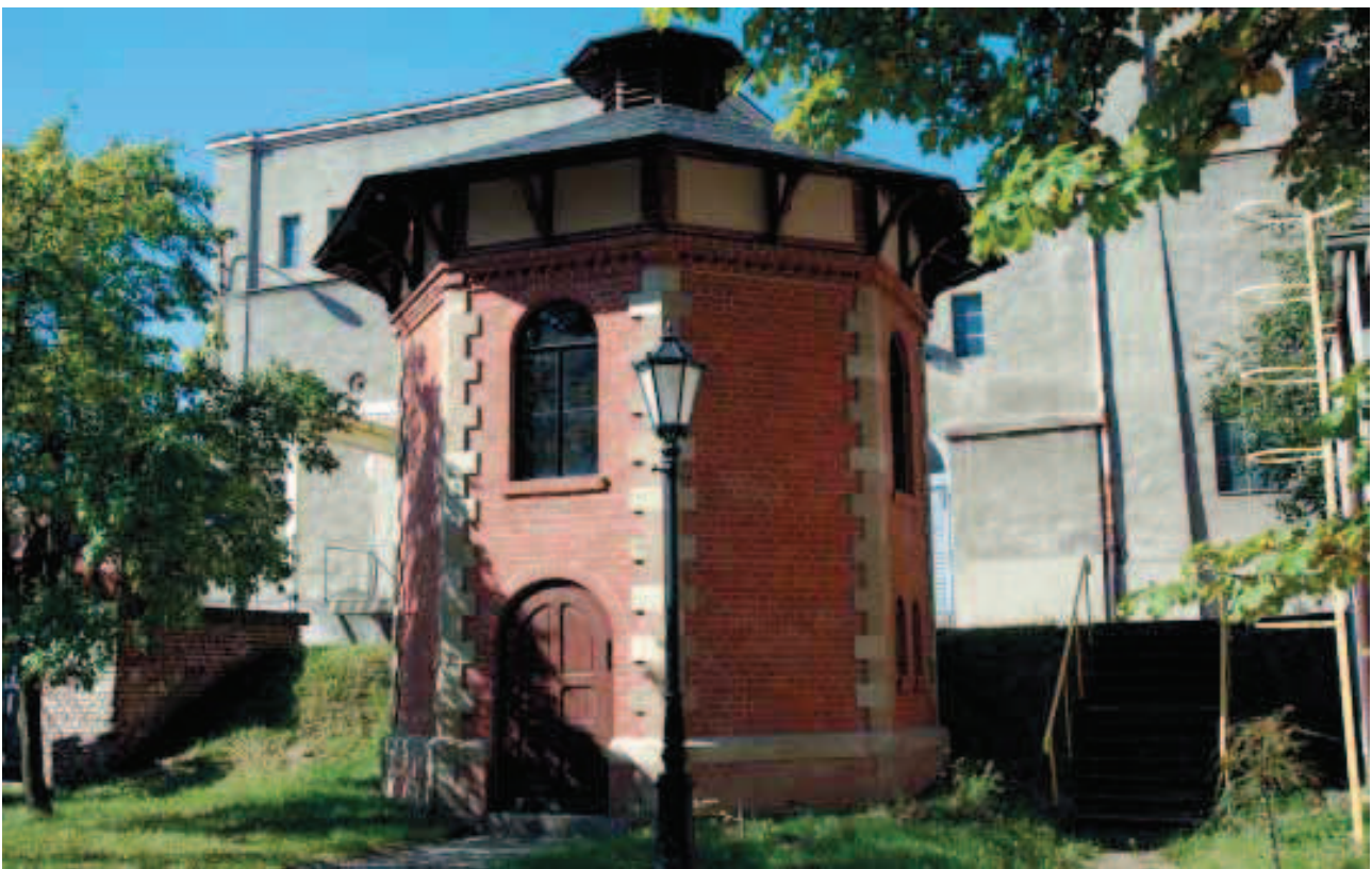
Szczecin. Budynek pierwszej studni wodociągowej z 1865 r., dzisiaj minimuzeum szczecińskich wodociągów (foto ZWIK Szczecin)
