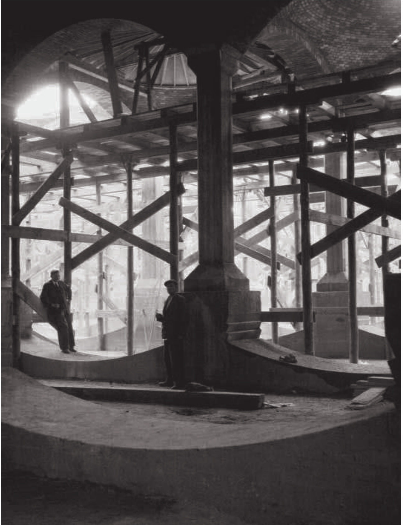
Wnętrze zbiorników wody w Łodzi. 1935-1937 r. Wodociągowcy mówią o nich: „podziemna katedra”. Sklepienie każdego zbiornika tworzy 100 ceglanych kopuł, wspartych na 81 kolumnach (arch. ZWiK Łódź)
