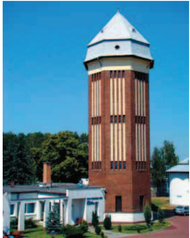
Nowy Tomyśl, woj. wielkopolskie – wieża ciśnień z 1906 r., wys. 32 m, zbiornik 100 m 3 , stacja pomp tłokowych napędzanych silnikami na gaz miejski (foto P. Janik)
