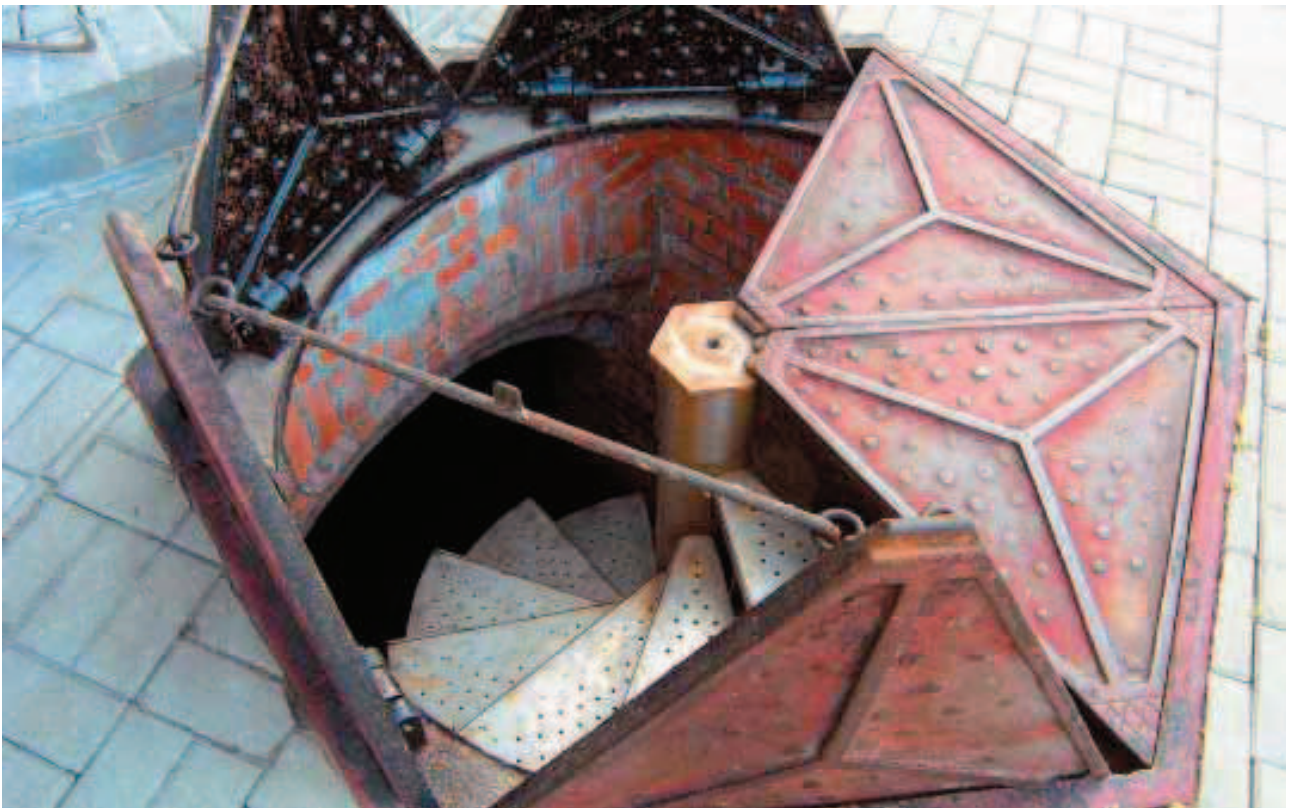
Łódź. „Gwiazda” (poniżej) – nietypowy wjazd do zejścia bocznego, prowadzącego do komory łączącej dwa najstarsze łódzkie kolektory i przelew burzowy. Budowę łódzkiej kanalizacji zaczęto właśnie od tych kanałów w 1925 roku, należą one do największych podziemnych budowli. Wrażenie robi burzowiec (powyżej) o przekroju dzwonu – bez trudu mógłby przejechać nim autobus komunikacji miejskiej (foto MPWiK Łódź)
