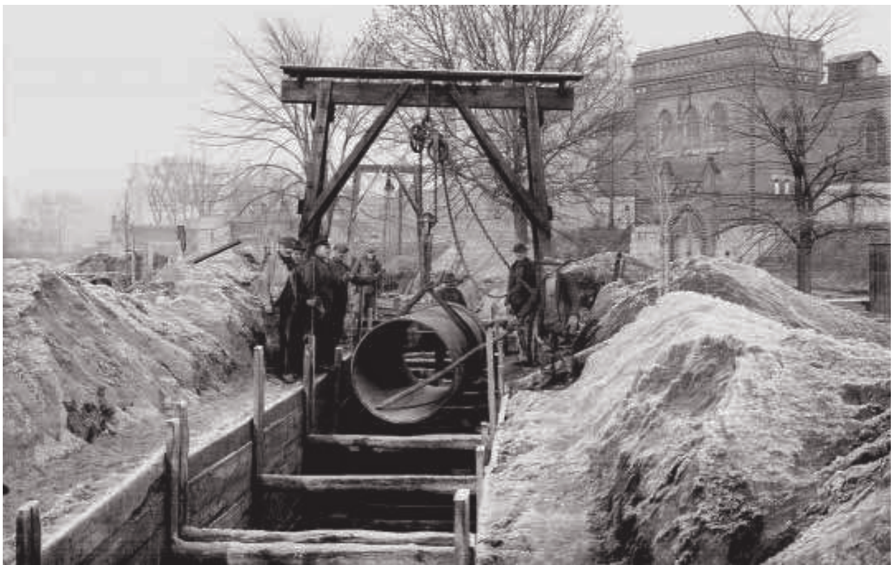
Renowacja rurociągu wody we Wrocławiu, w pobliżu odźelaziacza w zakładzie „Na Grobli” – 1936 r. (arch. MPWiK Wrocław)
