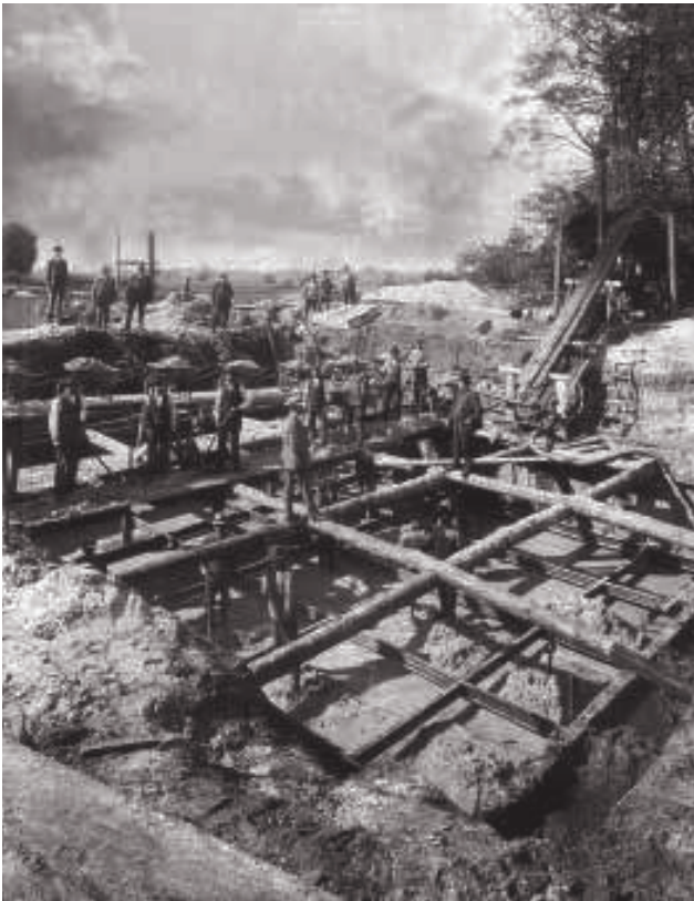
Kluczbork. Budowa przepompowni ścieków 1905 rok (arch. Hydrokom Kluczbork)
