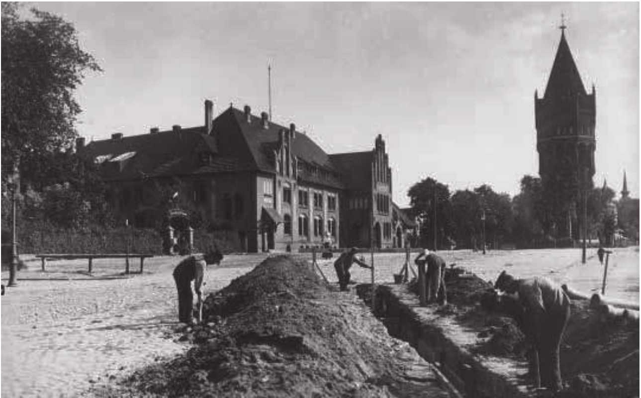
Malbork, woj. pomorskie. Budowa wodociągu w Malborku na placu Gdańskim (obecnie plac Słowiański) w 1906 roku, w tle wieża ciśnień (arch. Muzeum Zamkowe w Malborku)
