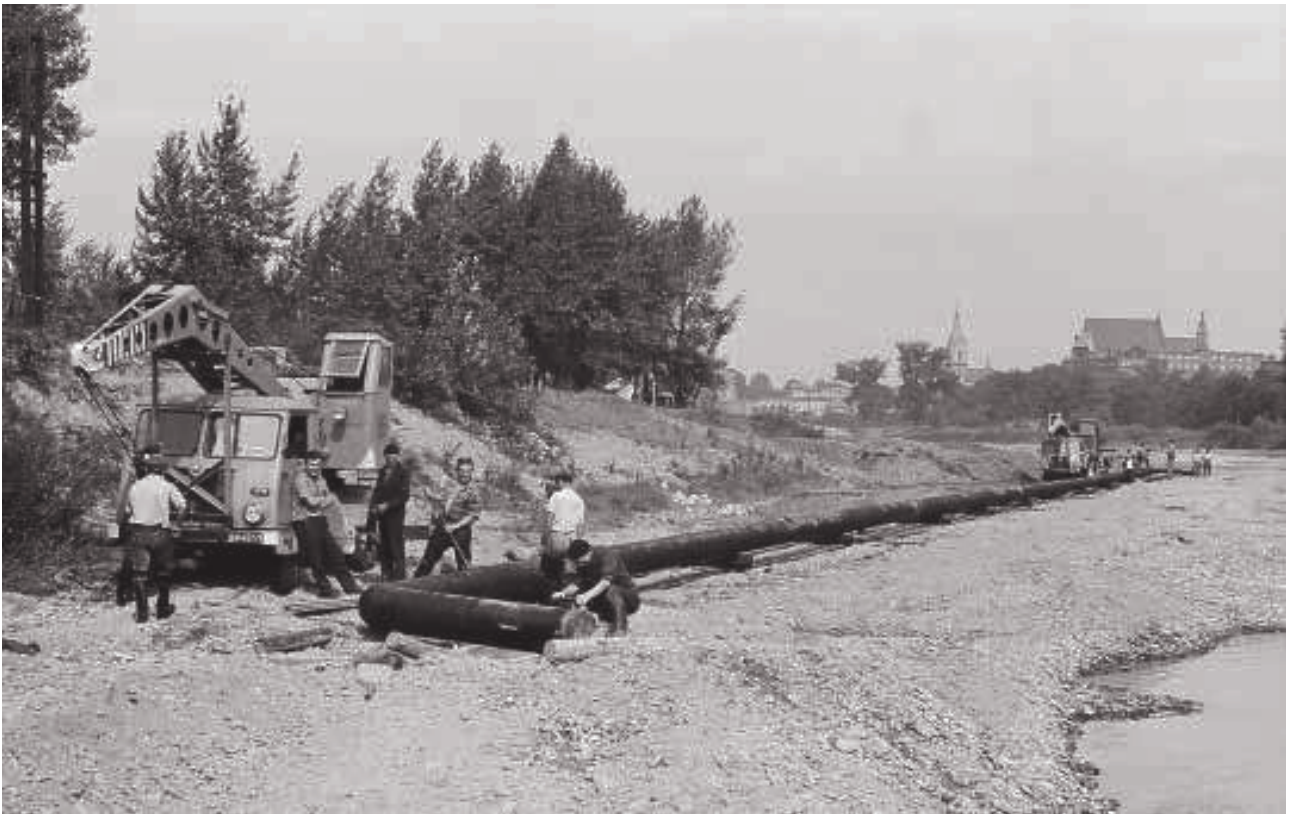
Oświęcim, woj. małopolskie. Budowa magistrali wodociągowej 1964 r. (arch. PWiK Oświęcim)
