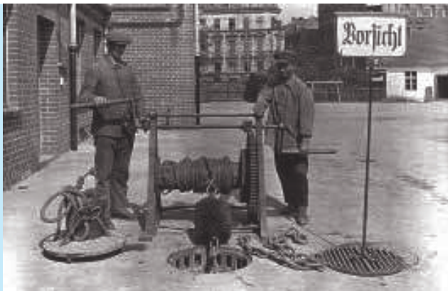
[74] Wrocław. Czyszczenie kanałów (arch. MPWiK Wrocław)
