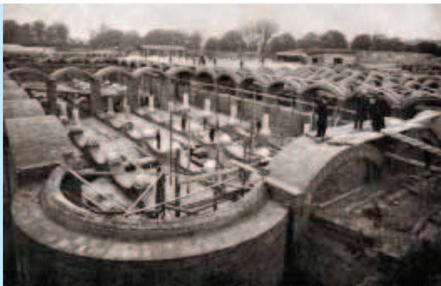
[39] Budowa filtrów powolnych w Warszawie (arch. MPWiK Warszawa)
