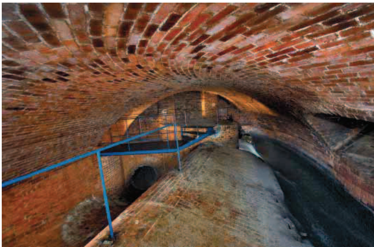
[76] Warszawa. Połączenie kanałów pod ulicą Karową i Krakowskim Przedmieściem (foto K. Kobus/TravelPhoto)
