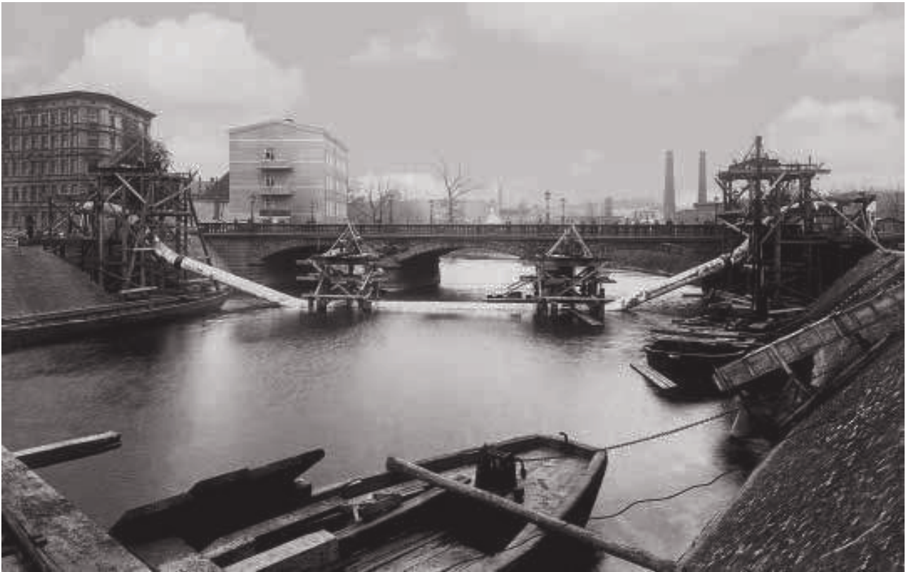
Budowa rurociągu z Zakładu Uzdatniania Wody „Na Grobli” we Wrocławiu przez rzekę Olawę – 1937 r. (arch. MPWiK Wrocław)
