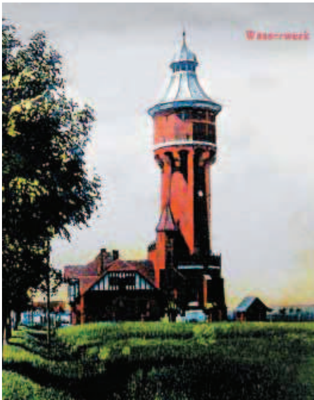
Kępno, woj. wielkopolskie. Wieża ciśnieniowa – 1905 r. (arch. Wodociągi Kępińskie)
