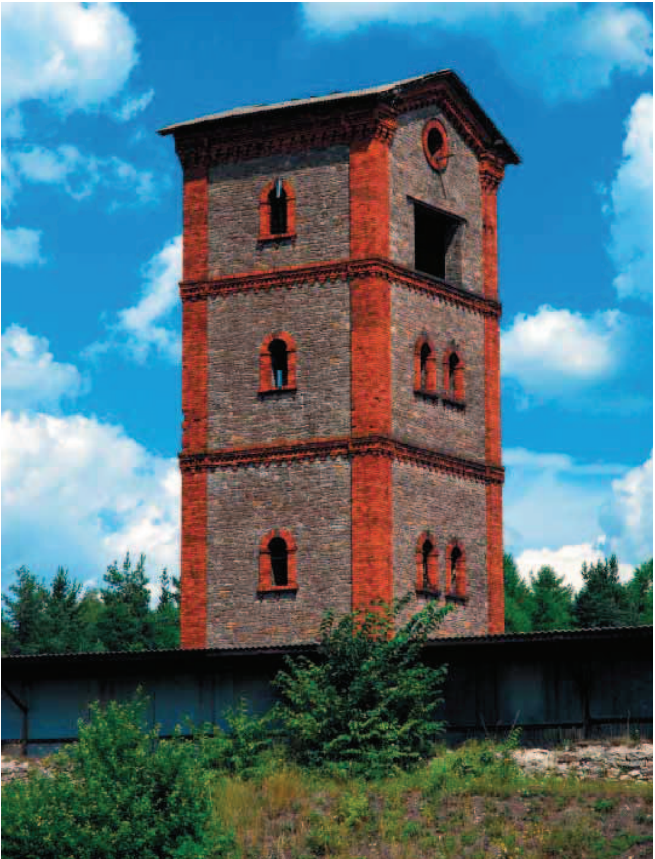
Furmanów, woj. świętokrzyskie – gichtociąg (1877 r.) czyli... winda wodna (wieża wyciągowa) – wykorzystywana w dawnych hutach jako urządzenie do transportowania wsadu do pieca hutniczego – działała dzięki przepompowywaniu wody pomiędzy zbiornikami na różnych poziomach i wykorzystaniu zasady naczyń połączonych (foto M. Kucharczyk)
